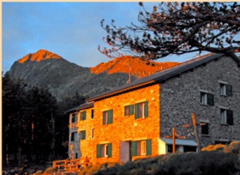
Pyrénées Orientales - Le Canigó 2784 m - le Refuge des Cortalets 2150 m
